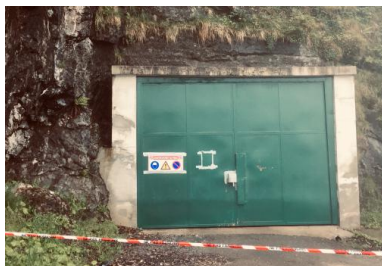
L'entrée de la mine de Salau. © PP
